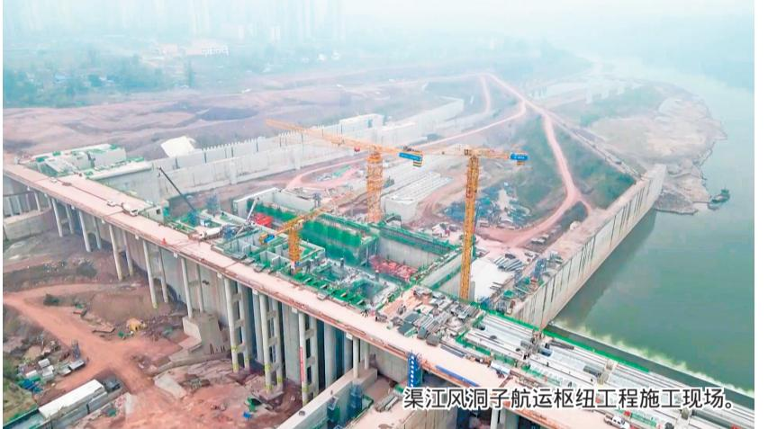
片坝顶预制梁生产等施工任务。”中交四航局渠江风洞子航运工程部部长赵磊介绍，当前发电厂房主体完成90%，鱼道坝及鱼道施工完成65%，船闸、发电厂房及泄洪冲沙闸金属结构
